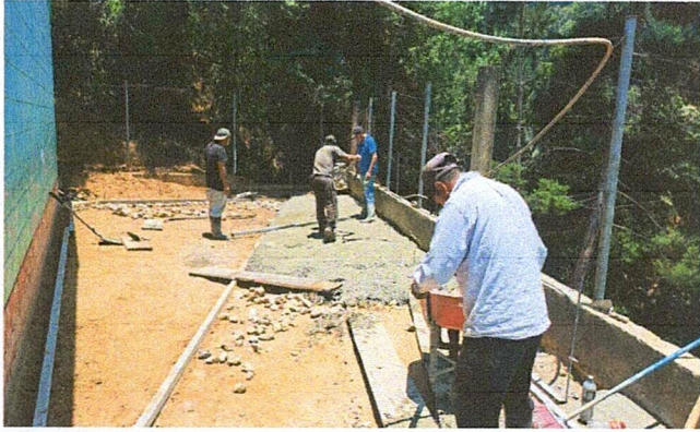
Foto 1: MEJORAMIENTO LOSA DE PATIO
