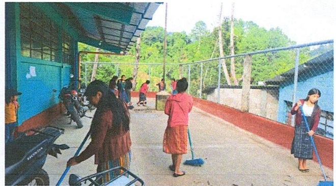
Foto 4: MEJORAMIENTO DE ZOCALO CON PINTURA COLOR ROJO OXIDO
